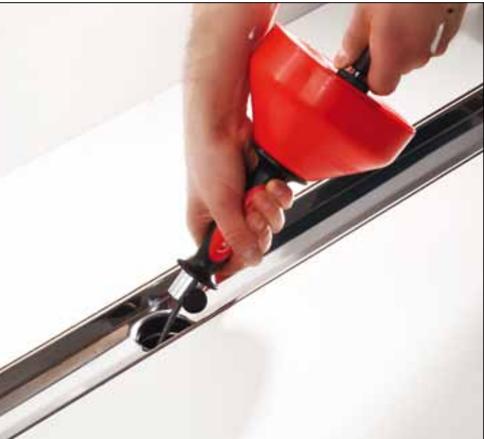
Pulire il tubo di uscita con una piccola molla flessibile manuale.
