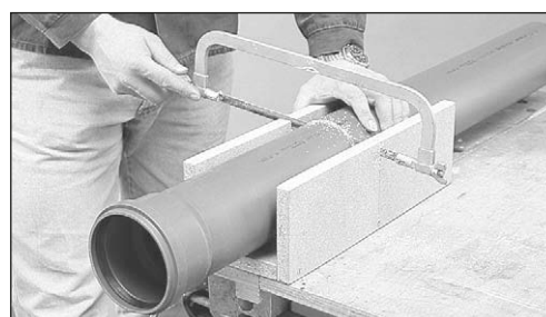
(BILD 20) Kapning med fintandad såg
