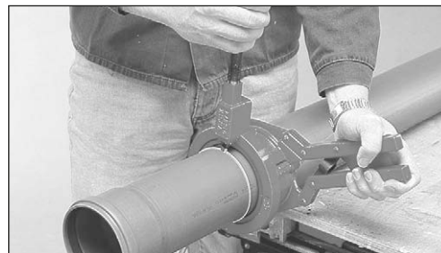
(BILD 19) Kapning med kap- och fasverktyg
