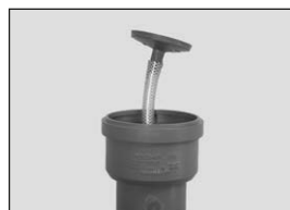
(BILD 55) För in slangnippeln så djupt som möjligt i slangen
