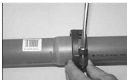
(BILD 12) Drag åt låsskruven till sitt stoppläge
