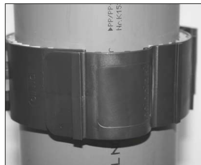
(BILD 74) Monterad klamma
