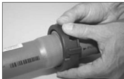
(BILD 11) Montera POLO-ASV över rörskarven och passa till så att klorna greppar i rörskarvens slätända
