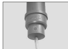
(BILD 52) Kondensatablauf in die Leitung einbauen
