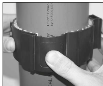
(BILD 73) Låsning av klamman
