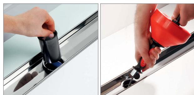
После очистки решетки или панели ее следует установить обратно в дренажный канал.
